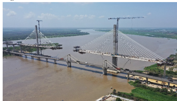
Figura 3. Vista lateral del puente durante su construcción
