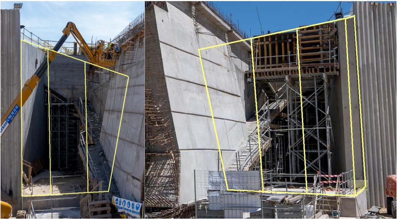
Figura 11. Adaptación de los paneles frontales del E-2, continuación de un muro in situ, a la geometría de la estructura
