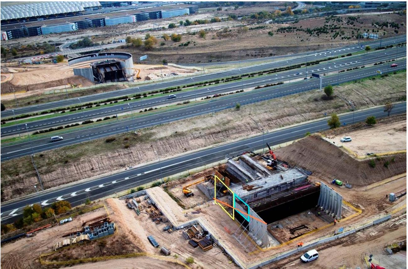
Figura 12. Vista del estribo E-1 tras el montaje de los módulos de aleta posteriores. Se representan los paneles de chapado y de cierre del lateral derecho, así como el derrame de tierras previsto
