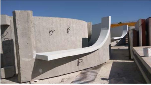
Figura 2. Pieza de túnel principal con ventana y collarín con terminación vertical
