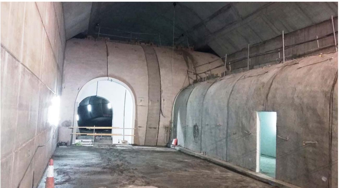
Figura 3. Aspecto de las bóvedas tras el montaje en el interior de la caverna
