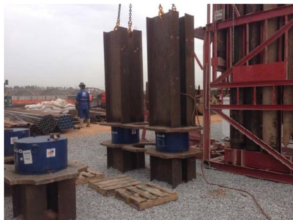
**Figura 4. Células de Osterberg en el solar.**
