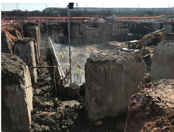
**Figura 7. Ejecución del descabezado de los módulos pantalla**
