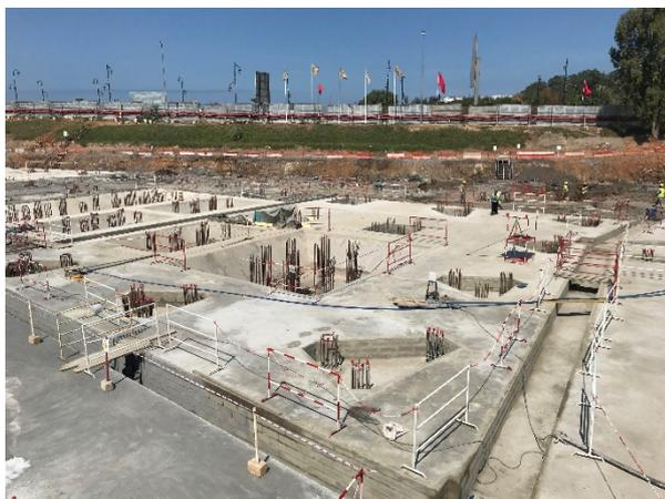
**Figura 5. Ejecución de la cimentación del zócalo**
