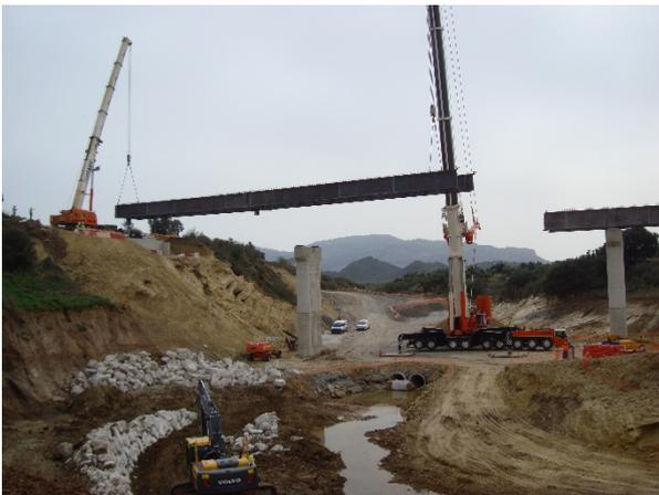
**Figuras 10 y 11. Dos instantes del montaje de los tramos.**
