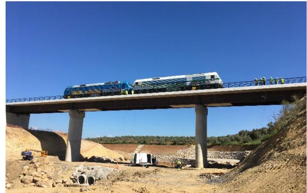
**Figura 12. Viaducto terminado durante la realización de las pruebas de carga.**
