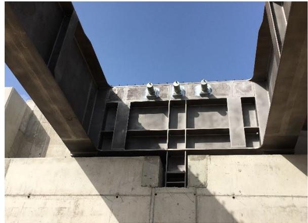
**Figura 9. Vista de la riostra del estribo fijo.**
