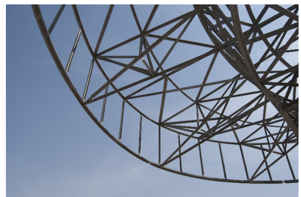
Figura 5. Celosía perimetral tipo Vierendeel.
