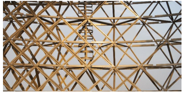
Figura 7. Vista entramado pieles estructurales.
