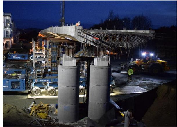
Figura 11. Imagen de pila 4 del GS-bru con tubos de hormigón. Por cortesía de Søbstad AS.
