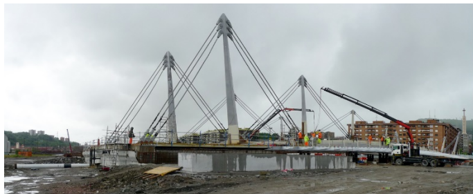
Figura 8. Puente de Zorrotzaurre. Construcción del puente sobre tierra y el puente como puerta de entrada
