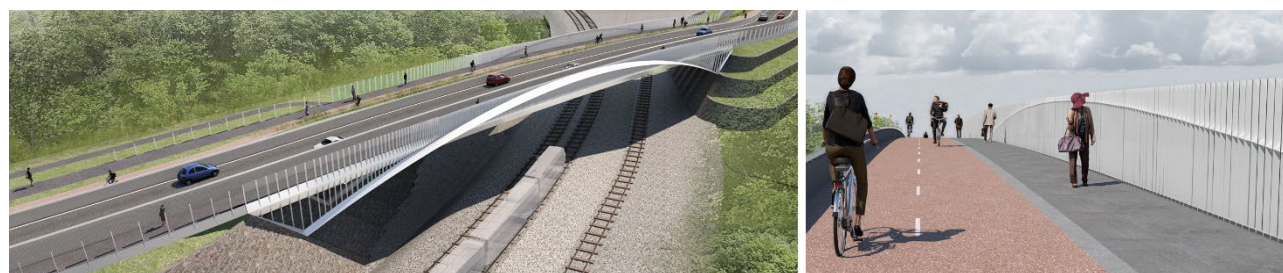
Figura 10. El puente ECML en York sirve de puerta de entrada tanto para sus usuarios como para los del ferrocarril
