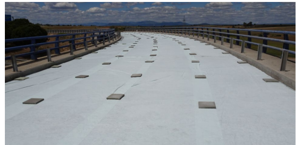
Figura 16. Curado del hormigón con geotextil humedecido en todo el tablero.
