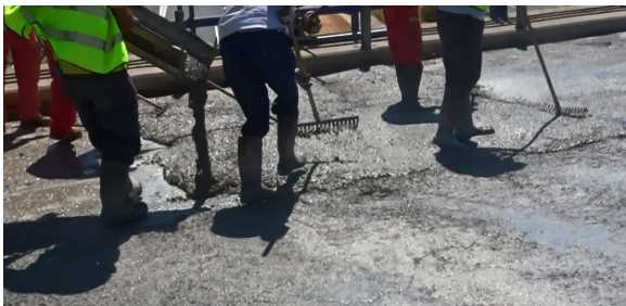
Figura 14. Ejecución de hormigón desde hormigonera en la segunda mitad de una sección.
