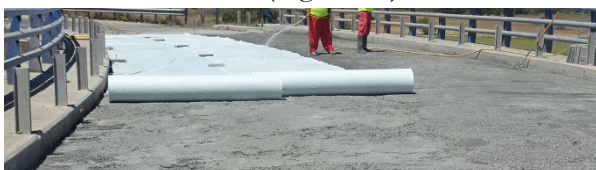
Figura 15. Riego de curado tras fraguado y disposición de geotextil humedecido.
