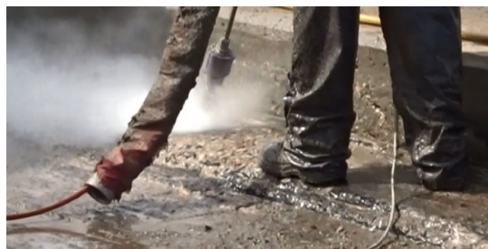
Figura 12. Limpieza con agua a elevada presión con lanza manual
