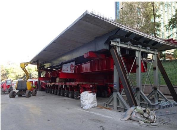
El transporte del nuevo vano mixto hasta la estructura se realiza en horario nocturno, con la misma secuencia de cortes de tráfico que para la operación de retirada. El conjunto *carro-estructura metálica auxiliar- vano mixto* se transporta
