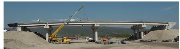
Figura 3. D4. Paso superior. Montaje de Vigas
