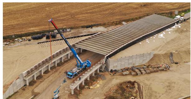
Figura 7. Pérgola. Colocación de vigas.
