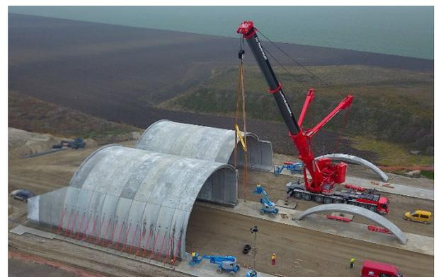
Figura 13. Ecoducto. Colocación de anillos.
