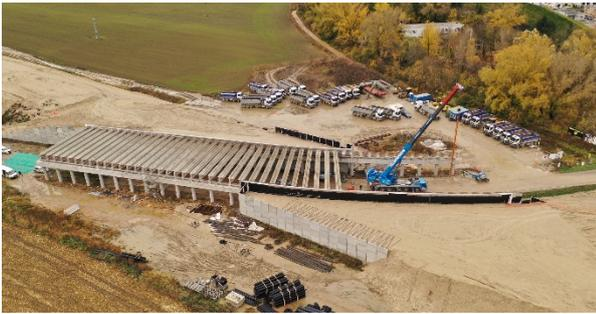
Figura 8. Pérgola. Abanicado de vigas en curva.
