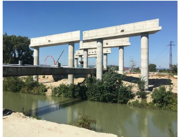
Fig.6 Puente Refinería. Pilas-pilote junto a canal.
