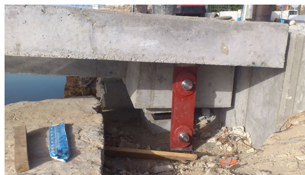
Figura 4. Biela metálica antilevantamiento en estructura en construcción.
