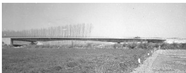
Figura 5. Fotografía de archivo del puente recién construido.
