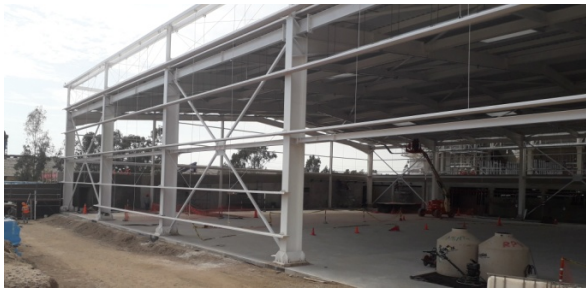
Figura 26. Zona de Calentamiento: estructura lateral.
