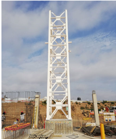
Figura 19. Pilar de la cubierta metálica.
