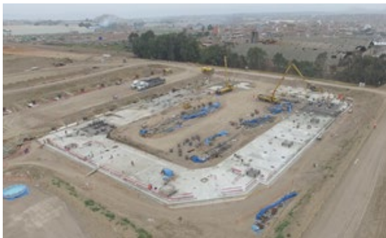
Figura 4. Losa cimentación: Zona de Competencia.
