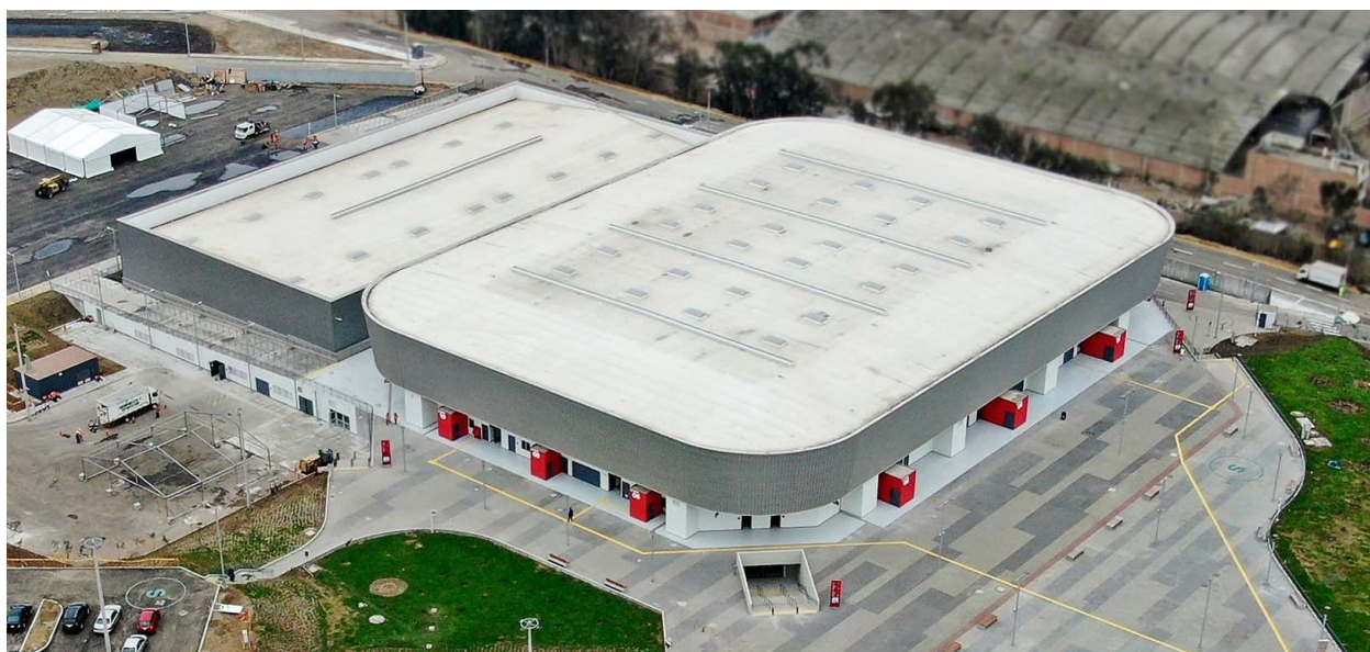
Figura 1. Vista general del Polideportivo acabado.
