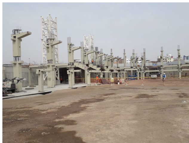
Figura 10. Montaje de los pilares prefabricados.
