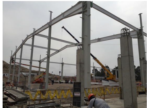
Figura 25. Zona de Calentamiento: pórtico frontal.
