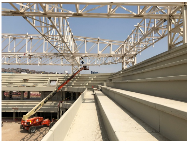
Figura 14. Vista interior de las gradas.
