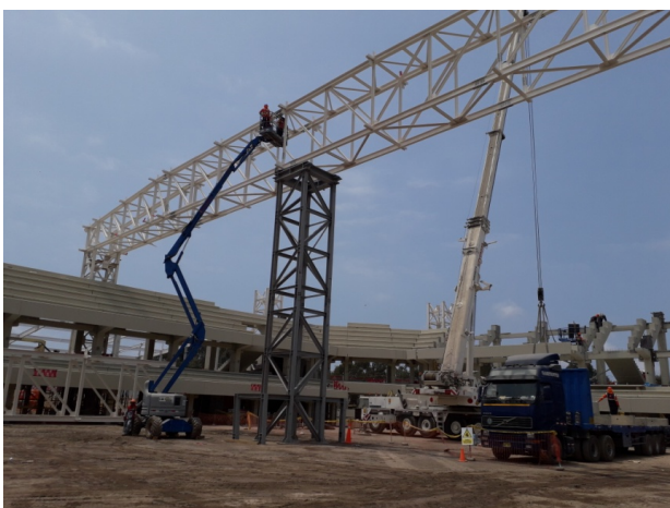
Figura 20. Montaje de un pórtico principal.
