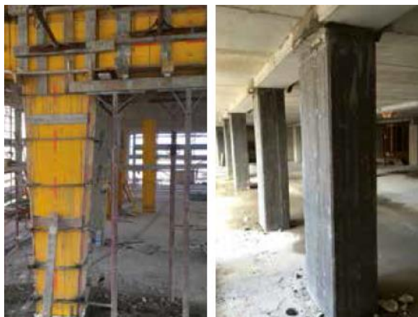
Figura 11. Refuerzo de pilares de hormigón
