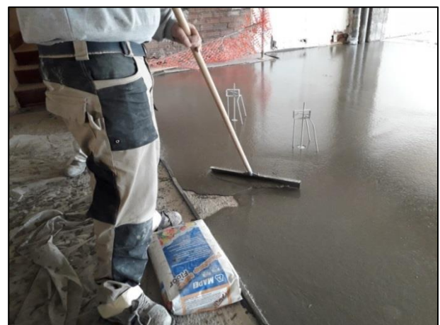
Figura 18. Extendido y control de espesores
