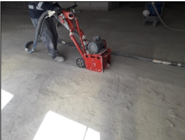
Figura 15. Preparación del soporte
