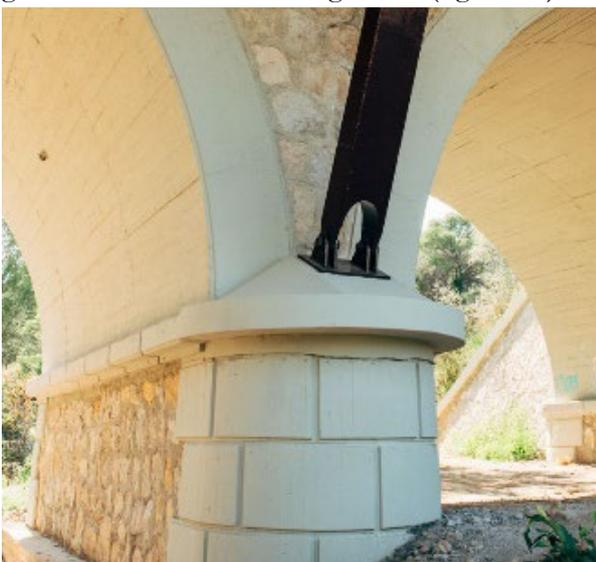
Figura 10. Detalle del apoyo en pila (foto: Marta González).
