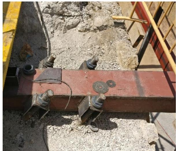
Figura 11. Detalle del anclaje de los micropilotes.
