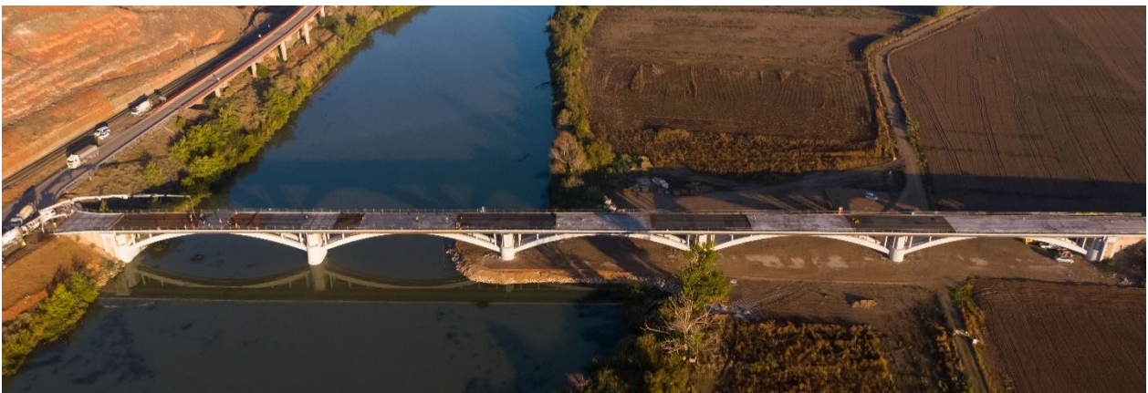
Figura 9. Losa hormigonada parcialmente. 25/10/2019.
