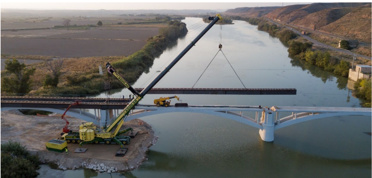
Figura 6. Montaje de viga metálica desde la península.
