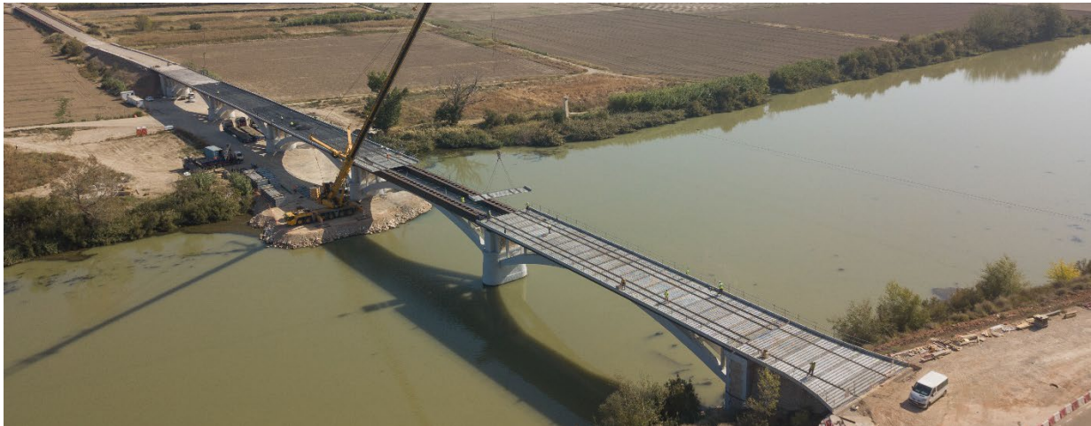
Figura 8. Montaje de pre-losas.
