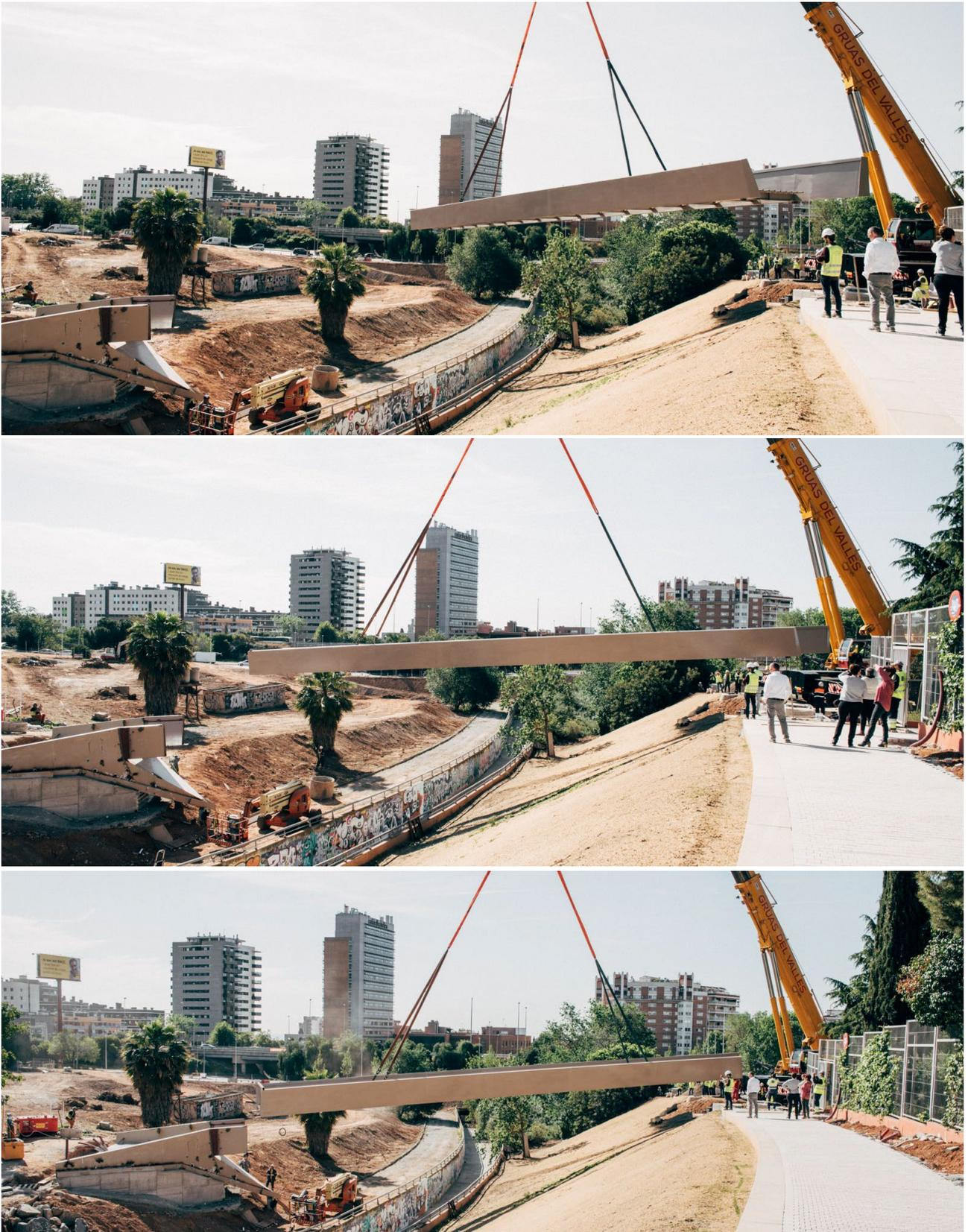
Figura 10. Proceso de montaje del tramo 2 de la pasarela.
