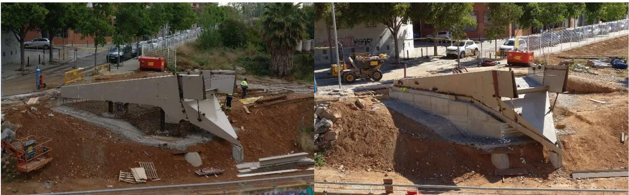
Figura 9. Tramo de estribo 2 de la pasarela montado (izquierda) y estribo 2 hormigonado con jácenas embebidas (derecha).
