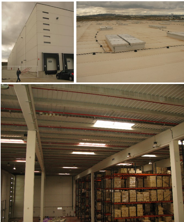
Figura 1. Vistas generales de la nave.
