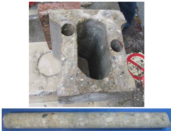
Figura 8. Microtestigos de hormigón extraídos para su ensayo.
