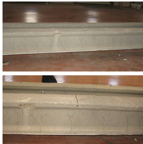
Figura 6. Fisuración por flexión desarrollada en las correas que fueron sometidas a una prueba de carga.
