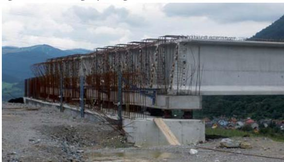
**Figura 5. Detalle de estribos con diafragma en Eslovaquia.**
