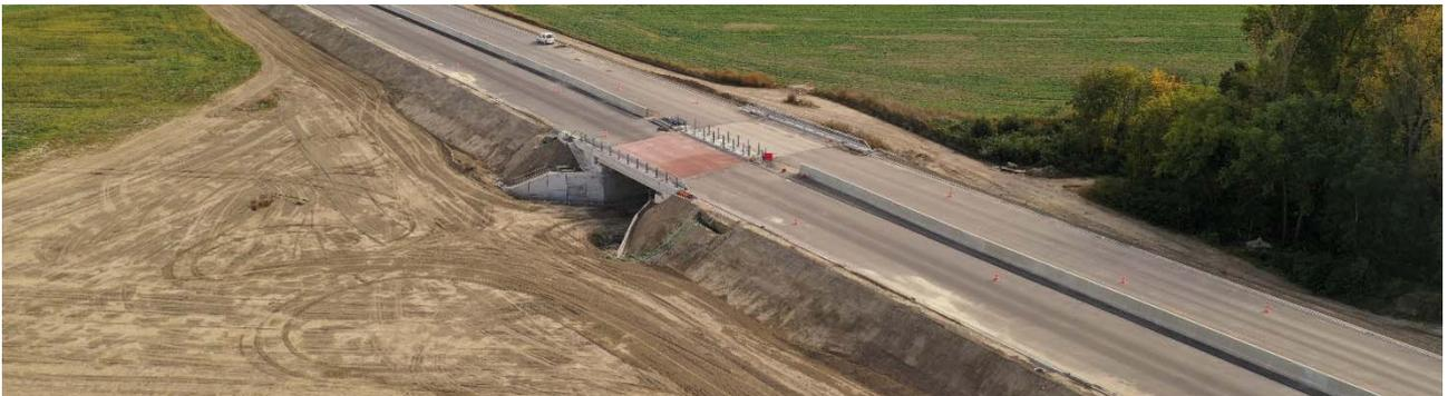
**Figura 17. Puentes de vigas de 1 vano en R7, tramo Dunajská Lužná - Holice (Octubre 2019).**
