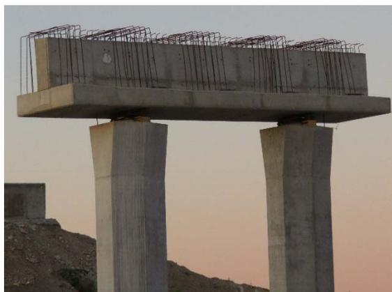
**Figura 4. Detalle de aparatos de apoyo tipo POT en pilas.**
