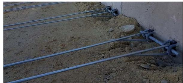
Figura 9. Flejes en cargaderos de estribos
