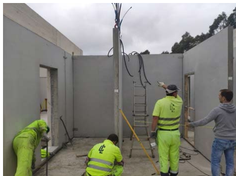
Figura 18: Montaje de los tabiques interiores objeto de esta investigación
