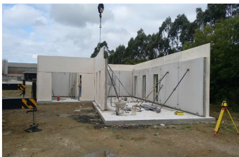
Figura 17: Montaje del módulo
