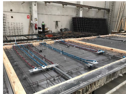
Figura 15: Tabique con instalaciones colocadas.
