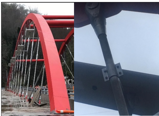
Figura 12. Fijación de iluminarias directamente en las péndolas.
