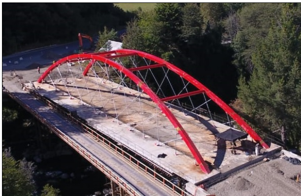
Figura 1. Puente Manchuria en construcción.
