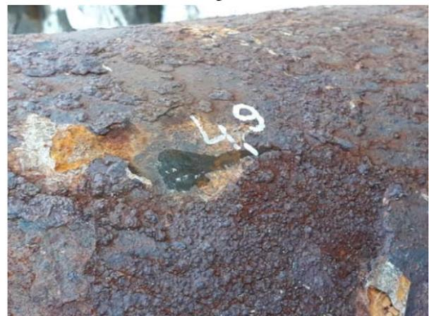
Figura 21. Corrosión en pilotes
