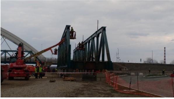
Figura 33. Desmontaje vano 2
