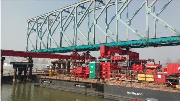
Figura 28. Descarga vano 4
