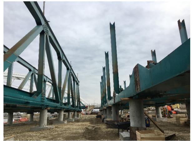
Figura 30. Vanos 2 y 5 sobre plintos durante desmontaje
