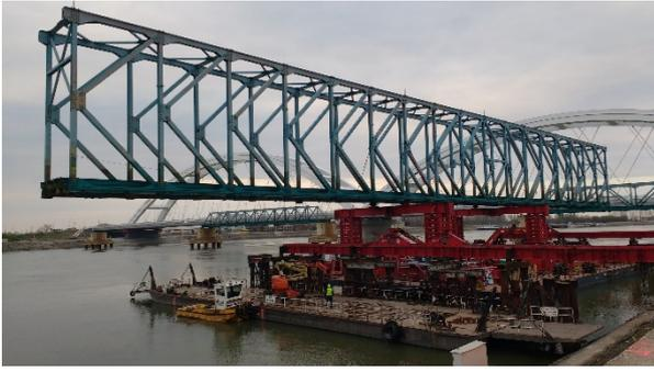
Figura 27. Posicionamiento de pontona en el muelle.
