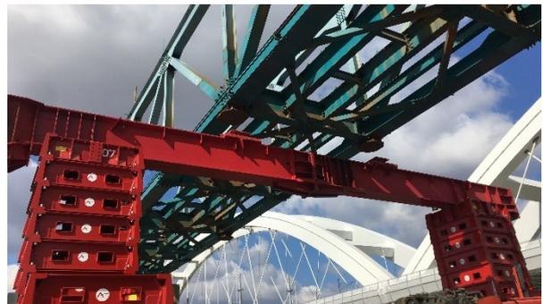
Figura 10. Colocación de pontona en posición
