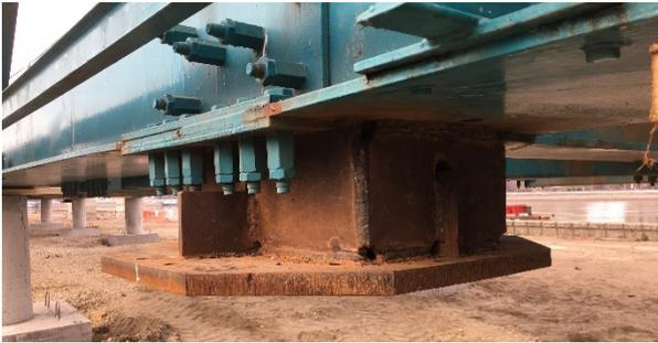
Figura 11. Pieza interfaz entre pontona-estructura
