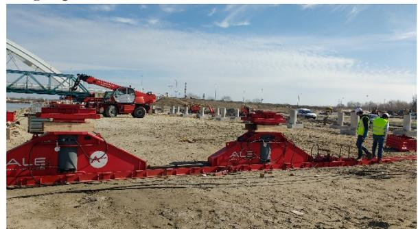
Figura 26. Patines de deslizamiento
