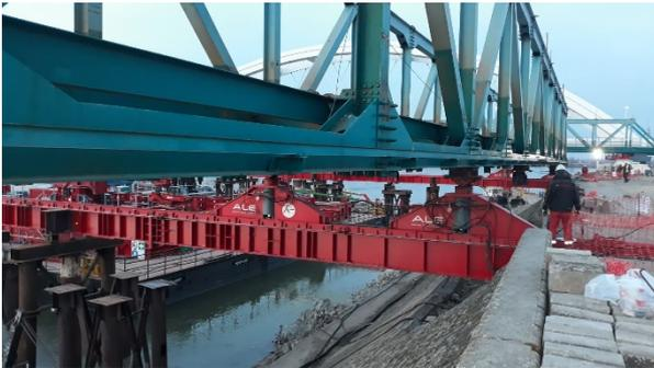
Figura 29. Deslizamiento vano 2
