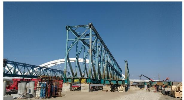
Figura 31. Vanos 2, 4 y 5 durante desmontaje
