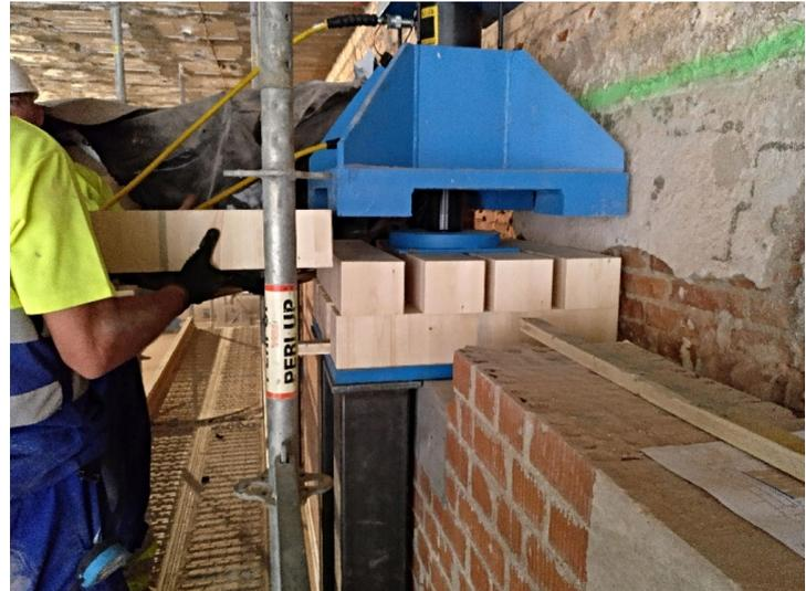
Figura 8. Módulos del proceso de descenso de forjado.
