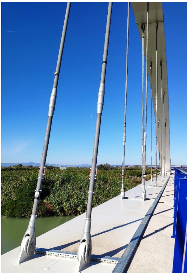
Figura 4. Extensómetro de cuerda vibrante (2) y regleta de cables
