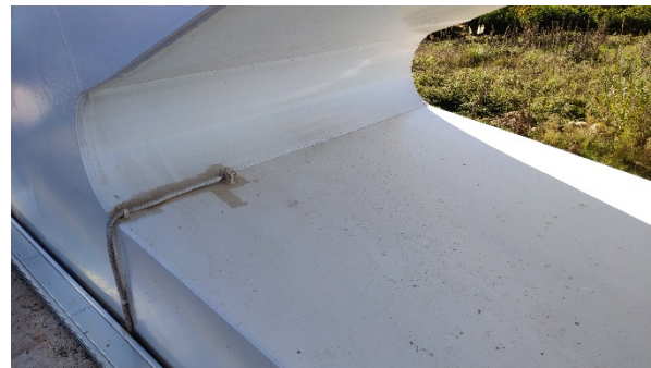
Figura 7. Sonda térmica en arranque arco
