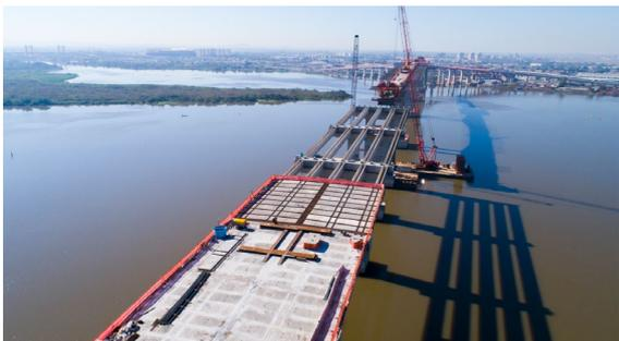
Figura 20. Elevada pesada durante construcción
