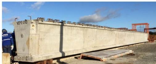
Figura 24. Foto viga prefabricada
