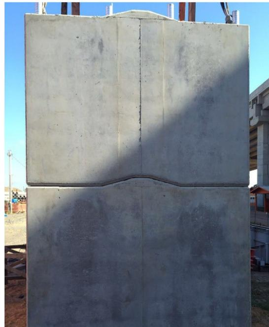
Figura 17. Fuste prefabricado
