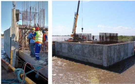
Los pilares ubicados en los extremos del puente principal se ejecutan en segmentos prefabricados, con secciones de celdas rectangulares, con encofrados de acero superiores e inferiores idénticos para un ajuste perfecto, lo que permite el uso de juntas secas.
