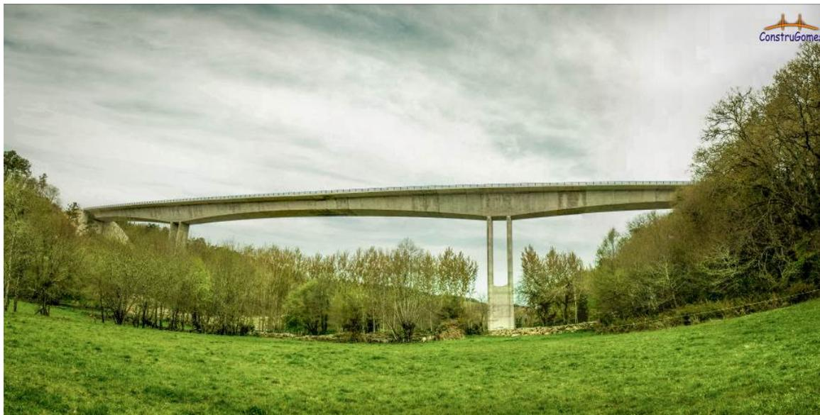
Para salvar estas luces se opta por una sección cajón de hormigón pretensado de canto variable con una parábola, de 8m de canto en la sección de pilas y de 4m en el centro del vano principal y en estribos. Las almas del cajón están separadas entre sí 6 m en la losa inferior sobre pilas y 10.08m en el centro de vano y tienen una inclinación de 117° y los vuelos son de 4.11m.
