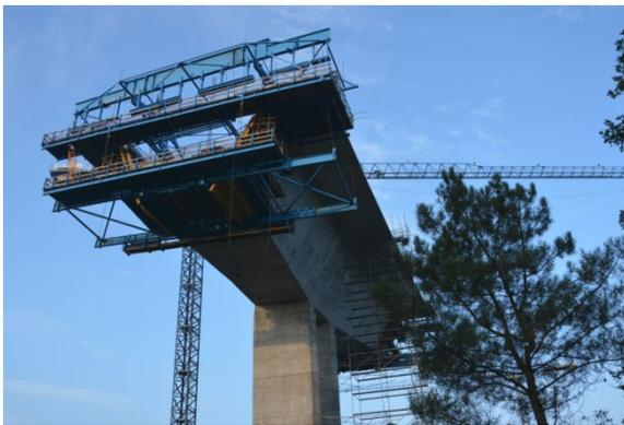
**Figura 4. Vista de la construcción en voladizo con carros de avance**
