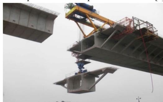
Fig. 20. Colocación de dovelas del tramo principal. Puente de Vidin. (CFC-FCC 2011)
