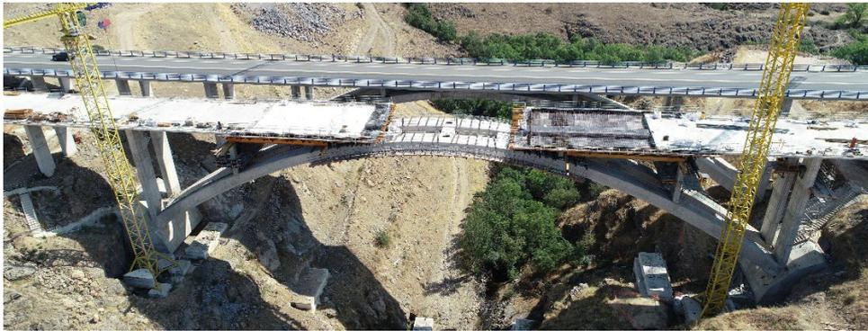
Figura 18. Ejecución de tablero, fases 5 y 6
