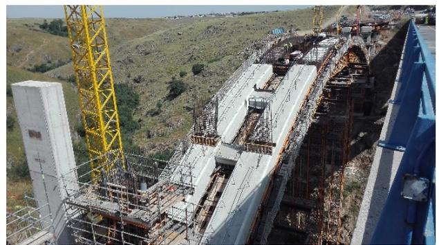
Figura 14. Hormigonado final del arco en zona de clave
