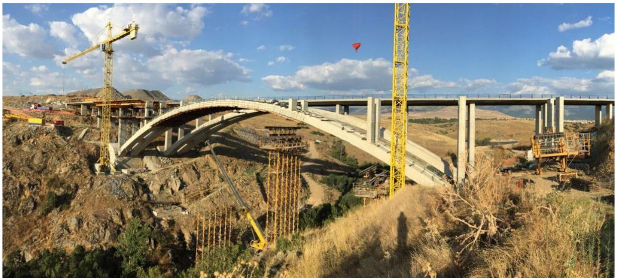
Figura 15. Vista general del descimbrado del arco
