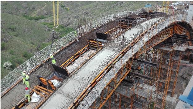
Figura 13. Hormigonado del fondo del arco
