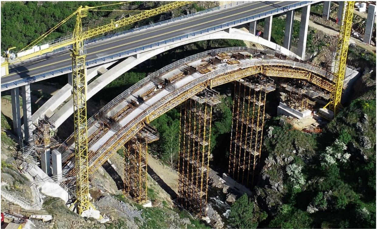
Figura 12. Vista general con el fondo del arco recién hormigonado
