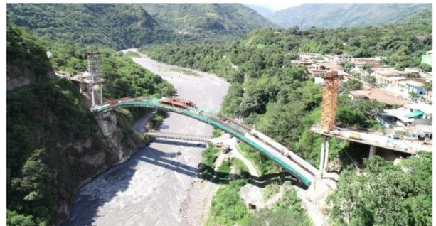
Figura 9. Arco en fase intermedia de hormigonado
