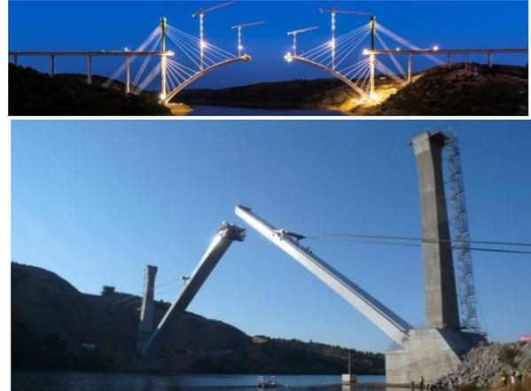
**Figura 2.** Construcción de arcos por voladizos sucesivos con atirantamiento provisional (puente de Alcántara CFC 2018) y por abatimiento (viaducto sobre el río Tera CFC 2014)
