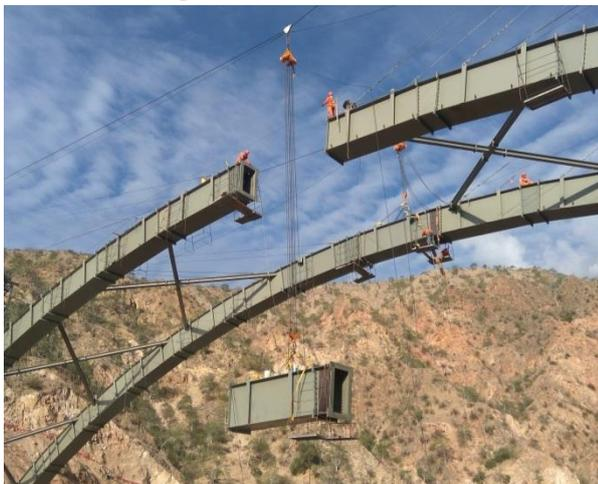
**Figura 18. Colocación de la pieza de clave.**
