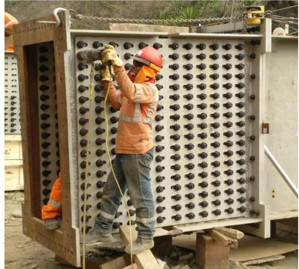
**Figura 13. Pieza de clave siendo preparada en obra antes de su colocación.**
