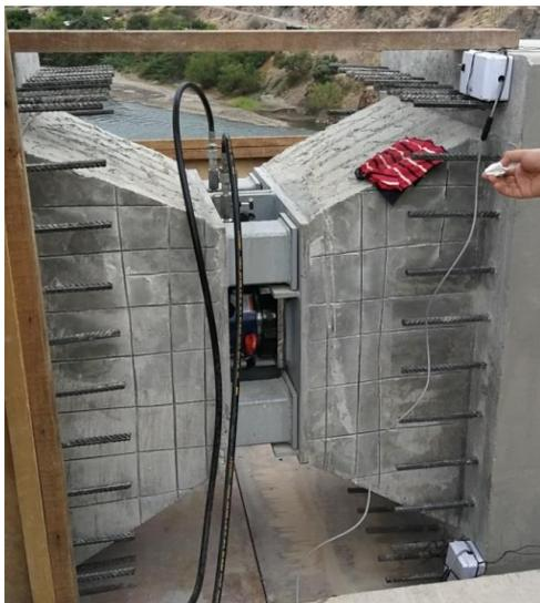
**Figura 19. Dispositivo de gateo en clave del arco.**
