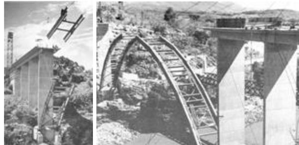
**Figura 3.** Cimbra autoportante para la construcción del puente "Belisario Domínguez". México [4]
