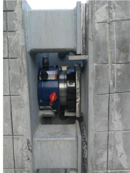
**Figura 20. Final de la maniobra. Observense las chapas adicionales dispuestas sobre los tetones de apoyo para proceder a la retirada de los gatos.**
