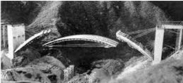
**Figura 1** Montaje de la cimbra autoportante para la construcción del arco de la Guaira. Caracas. Venezuela. E. Freyssinet 1962.
