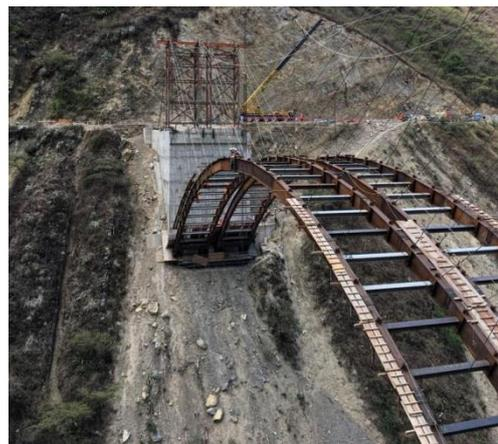
Figura 24. Cimbra de Tingo cerrada a la espera de la colocación de los encofrados.
