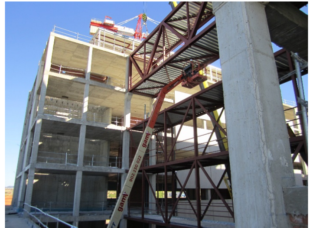
Figura 7 Detalle de la unión de la pasarela de hospitalización con edificio L.
