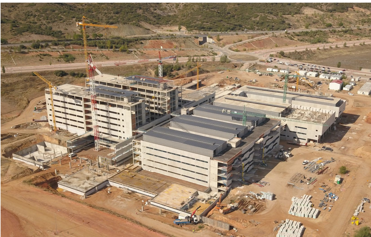
Figura 4 Vista aérea de la estructura desde el lado este.
