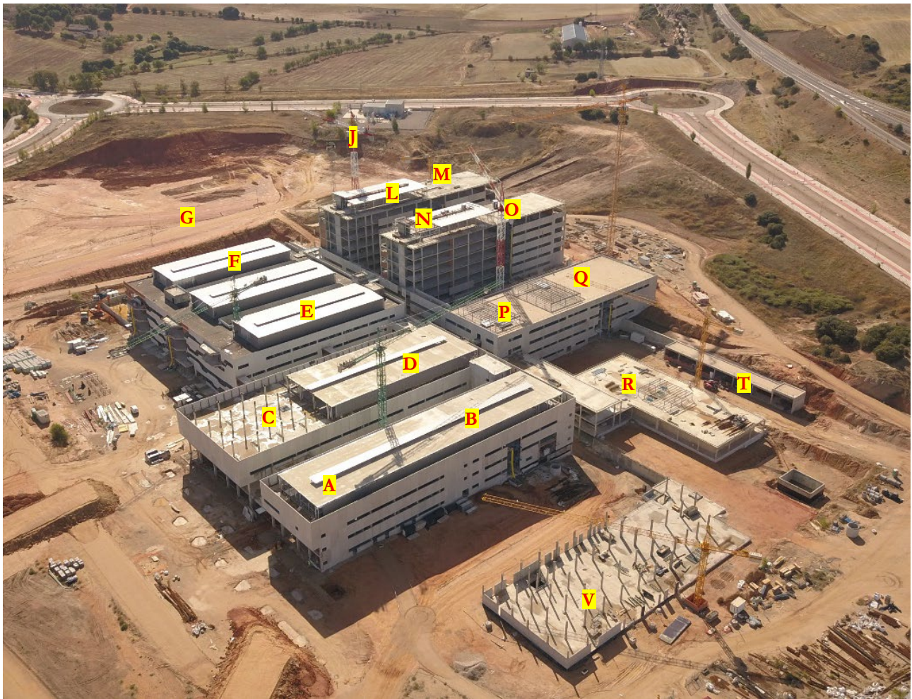
Figura 1 Vista general de la estructura del hospital desde el oeste.
