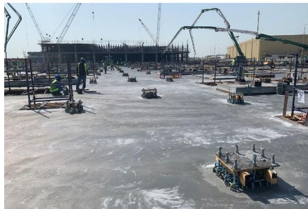
**Figura 10. Foto durante el hormigonado de la losa de cimentación del edificio RO.**
