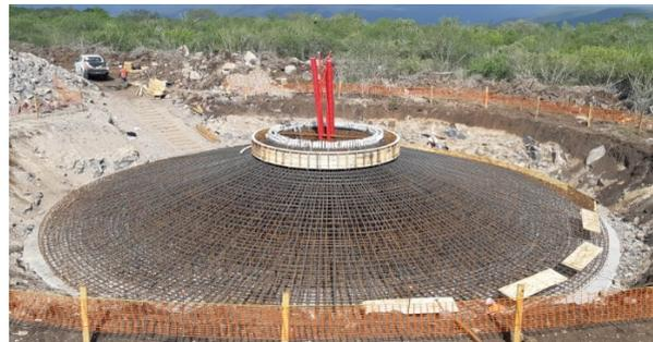
**Figura 9. Cimentación ferrallada y lista para el hormigonado (cortesía de Acciona Industrial).**
