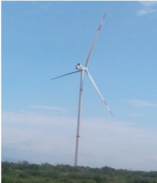
Figura 5. Aerogenerador Vestas V136-3.6 MW ya instalado en sitio (cortesía de Acciona Industrial).
