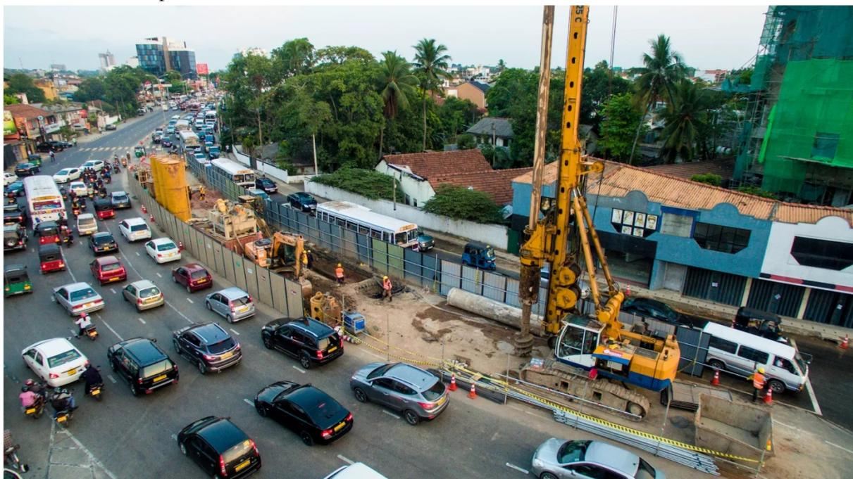
Figura 5. Construcción de los pilotes
