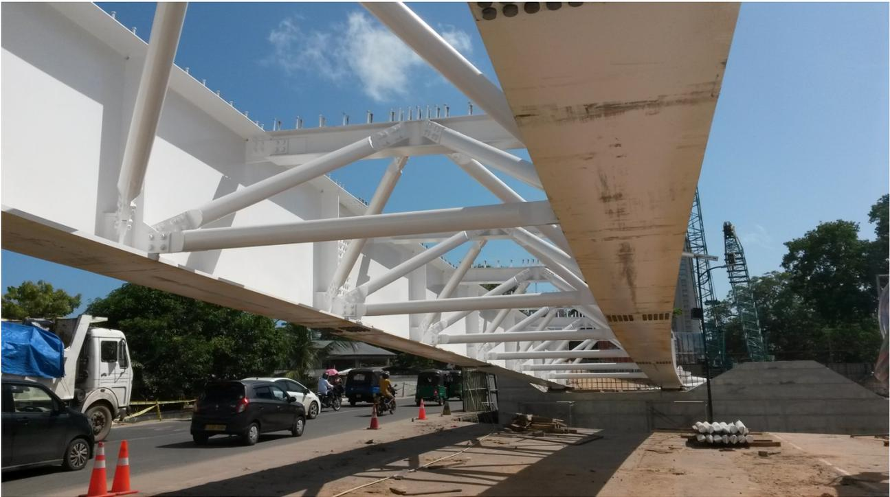
**Figura 6. Montaje de los tramos de tablero mediante grúas**
