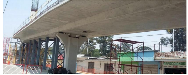
Figura 9. Vanos laterales sobre los apeos provisionales.
