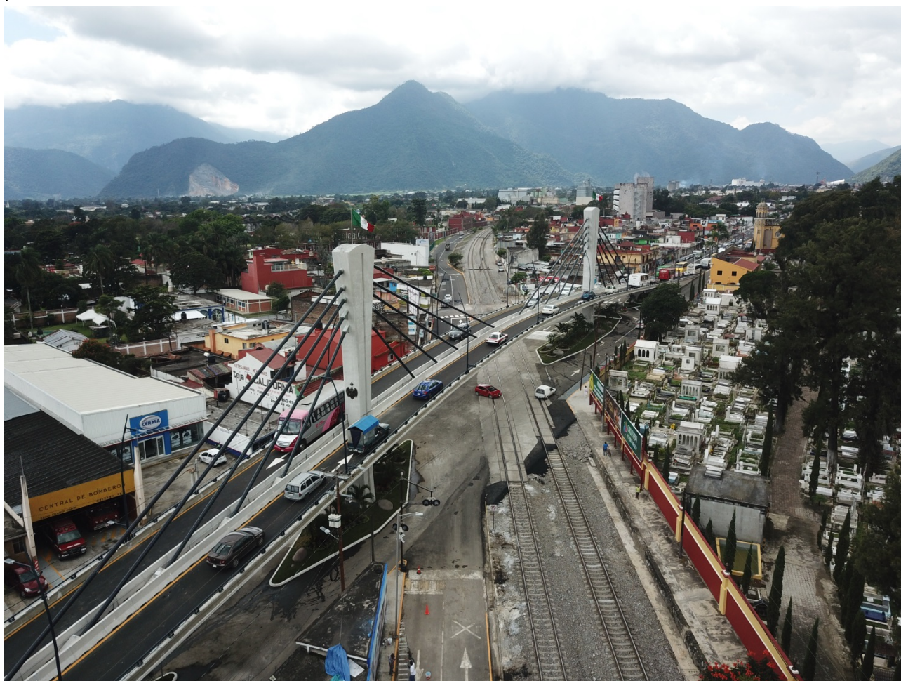
Figura 1. Vista general del Puente Real en Orizaba
