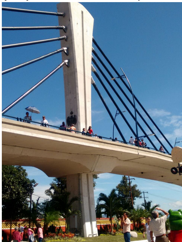
Figura 3. Torre del puente.
