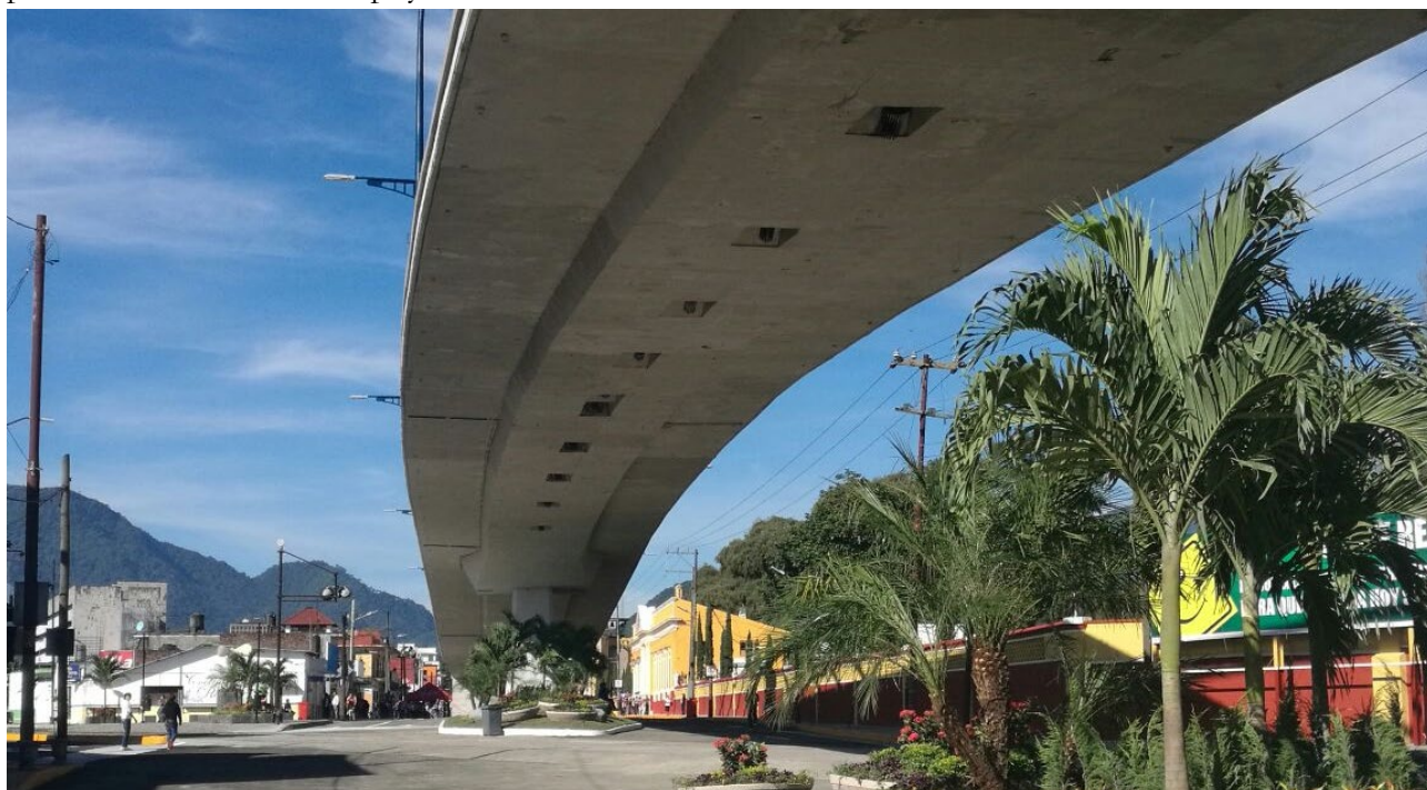
Figura 2. Vista inferior del tablero
