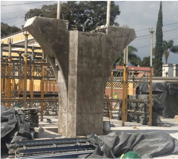
Figura 8. Pila del puente.
