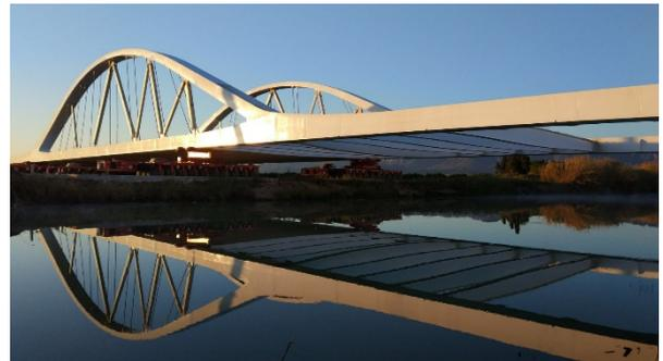
**Figura 19. Configuración de diagonales provisionales en arcos para crear una viga de gran canto durante el lanzamiento.**
