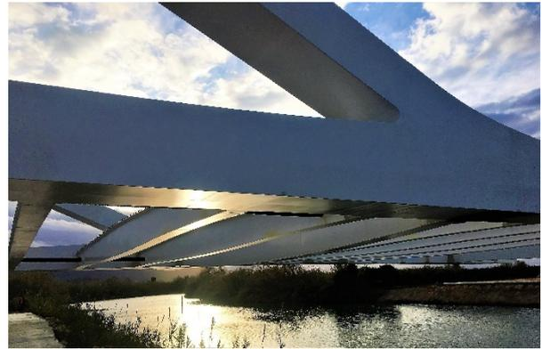
Figura 9. Vista general de las vigas transversales y su integración en el tablero.
