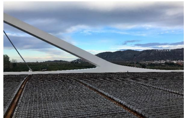
Figura 5. Variación de canto de la viga longitudinal e integración con el arco (I).
