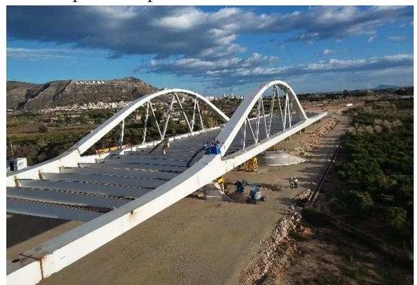
**Figura 20. Montaje de estructura metálica sobre apeos provisionales.**
