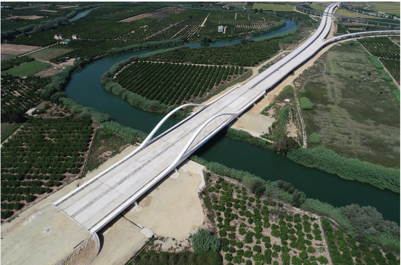
En los ejes de apoyos de pilas y estribo se disponen vigas transversales sección cajón a modo de viga riostra. Estas vigas tienen la misma variación de canto que las vigas transversales tipo, a excepción de las riostras de P2 y P3, que aumentan su canto hasta un total de 2.20m en centro de vano. Estas riostras, con mayor rigidez, controlan la deformabilidad transversal
