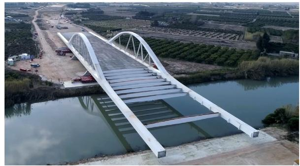
**Figura 18. Fase de máximo voladizo del lanzamiento.**
