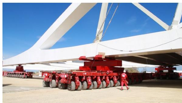
Figura 15. Plataformas SPMT durante el lanzamiento del tablero.
