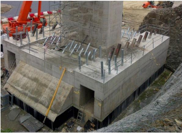
Figura 9. Anclajes pasivos en zapata de retenida
