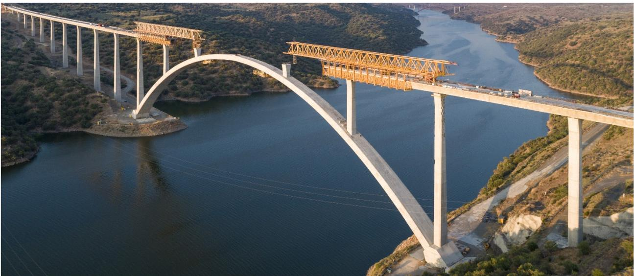
Figura 12. Ejecución de tablero sobre arco
