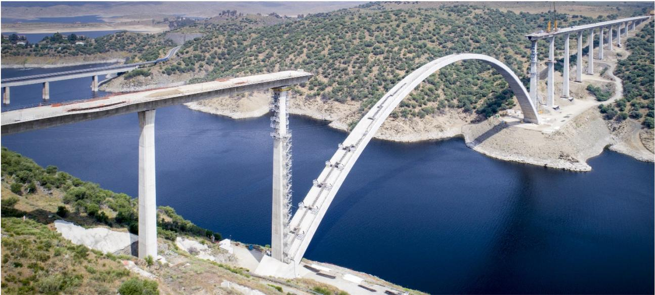
Figura 11. Final de ejecución de arco
