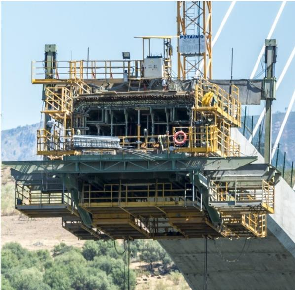
**Figura 6. Carro de hormigonado del arco**
