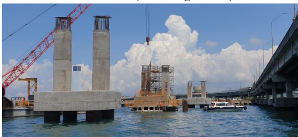
Figura 19. Cimentaciones y fustes de rampa On, a la derecha la estructura existente CSCR
