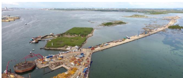
Figura 22. Vista aérea de relleno temporal para la ejecución del viaducto de Cordova.
