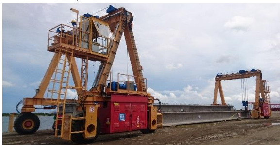
Figura 8. Acopio de vigas
