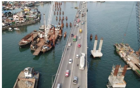
Figura 21. Vista de las cimentaciones de la rampa On y viaducto de Cebú con el cruce sobre la CSCR.
