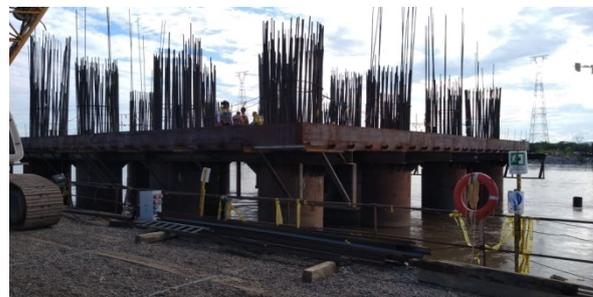
Figura 16. Prelasas para encofrado de encepados de pila P20 en el río
