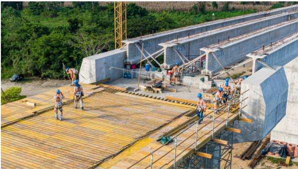
Las vigas de los vanos de acceso están pretensados con cordones de 14 mm con un trazado recto adaptado a la construcción, dando la continuidad entre vigas mediante una riostra de hormigón armada.
