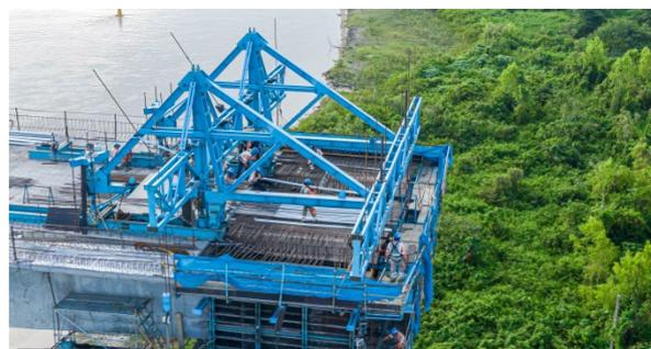
Figura 18. Carro de avance vista lateral
