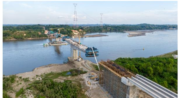
**Figura 12. Vista aérea del puente principal y cimbra calado máximo. La anchura total del tablero es de 12.95 m. Los vanos principales tienen una variación de canto parabólica entre 10.0 m en la sección de apoyos y 3.0 m en la sección de centro de vano.**
