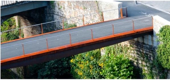
**Figura 2. Apoyo simple. Pasarela río Oria en Ordizia. 2010. Diseño: ANTA. Fotografía: Idoia Unzurrunzaga.**
