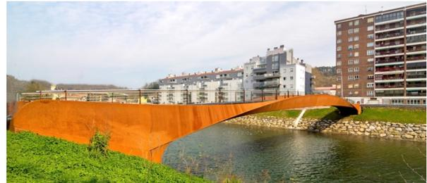
Figura 6. La intersección de las chapas exteriores genera una línea curva comprimida. Pasarela Martutene. 2016. Diseño: ANTA. Fotografía: Gorka Mirasolain.
