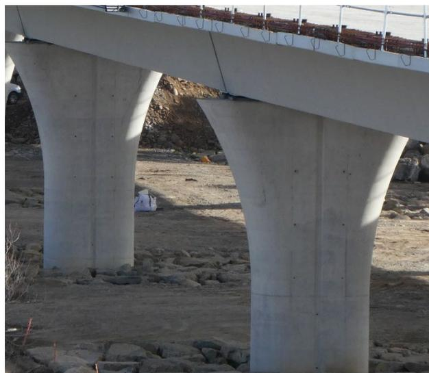
Figura 4. Pilas en vanos de acceso
