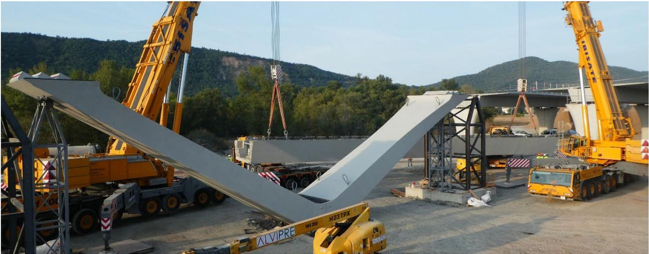
Figura 8. Izado de elementos prefabricados y unión de pilas en V
