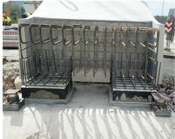
Figura 6. Apoyos y detalle de unión de pila en V
