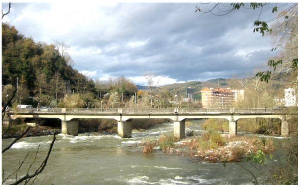
Las vigas de hormigón armado que soportan el tablero presentan una longitud aproximada de 13.40 metros, y a pesar de los acartelamientos existentes en sus apoyos presentan un comportamiento isostático. Probablemente, el incremento de canto en los apoyos sea un modo de incrementar la capacidad resistente de las almas frente a esfuerzos cortantes. En el primer vano de la margen derecha existe un antiguo canal, y la estructura es de la misma tipología que los anteriores vanos.
