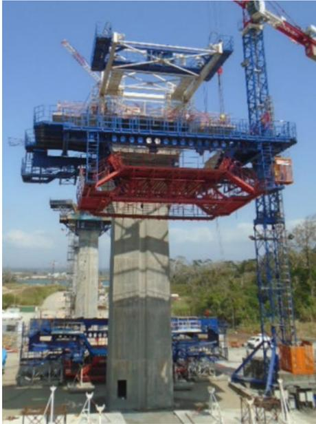
**Figura 14: Izado de carros y gatos de heavy lifting.**
