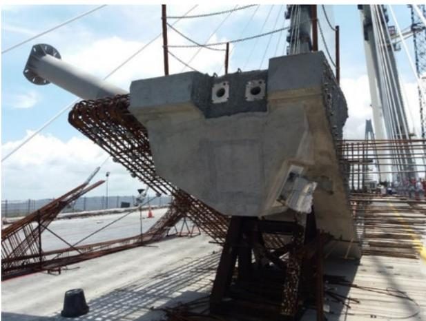
**Figura 18: Elemento de viga de tablero prefabricado con tubo de encofrado.**
