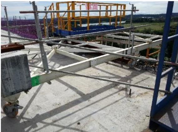
**Figura 15: Pasarela de acceso al borde del tablero para pretensado transversal tesado en segunda fase.**
