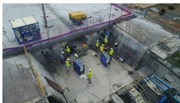
Figura 13: Pretensado de empuje del vano completo.
