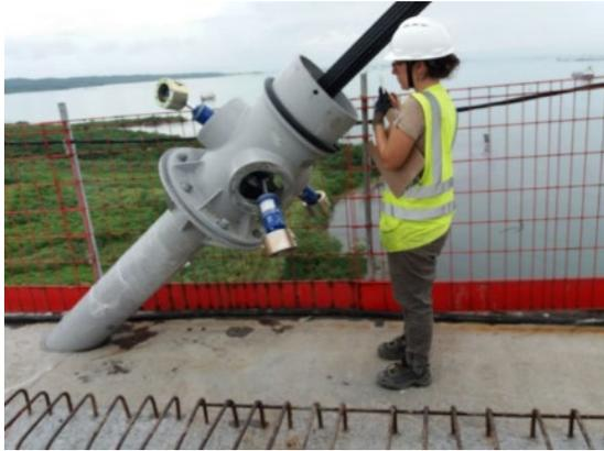
**Figura 10: Montaje de amortiguador IRD estándar**
