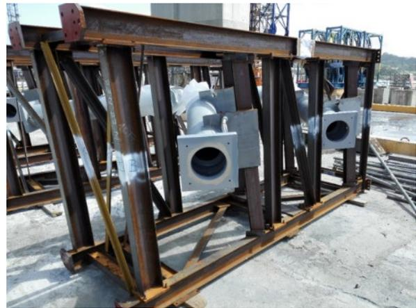
**Figura 19: Derrick con tubo de encofrado superior embebido dentro del paramento del pylon.**
