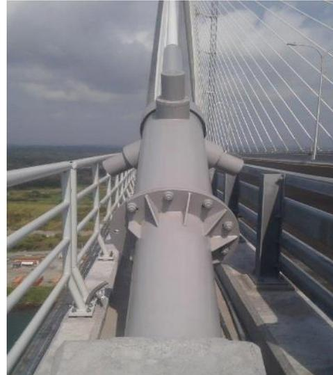
**Figura 11: Vista del amortiguador IRD y de los tubos expuestos con galvanizado + pintura C5MH.**
