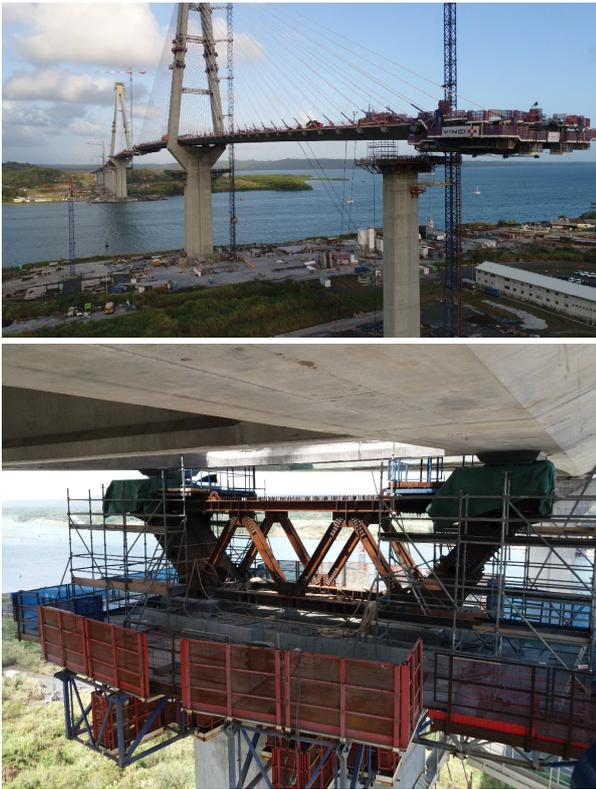
**Figura 20: Paso del carro por encima de las pilas de retenida y cabezal metálico izado y anclado.**
