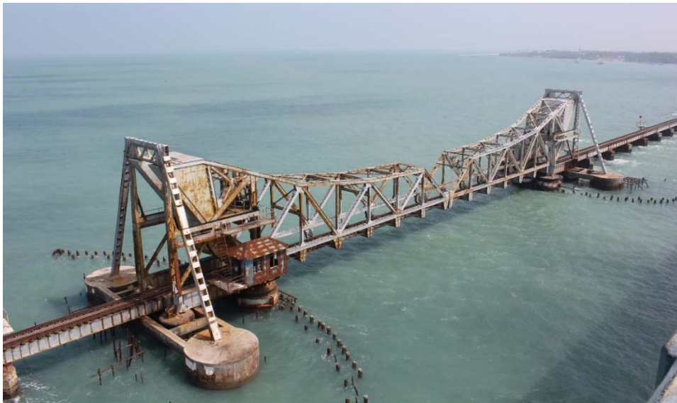
Figura 1. Puente móvil existente en la Isla de Pamban de tipología “Scherzer Rolling Bascule”
