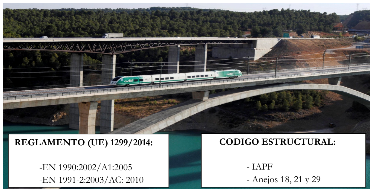
Figura 6. Aunque el Código Estructural regula las estructuras ferroviarias (Ej. –Puentes) , no incorpora en su articulado ninguna referencia al Reglamento (UE ) 1299/2014 de la Comisión Europea, de obligado cumplimiento, ni a la normativa europea en él explicitada.
