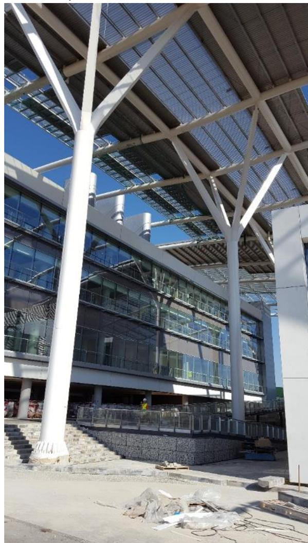
**Figura 15. Pilares de apoyo de la cubierta.**
