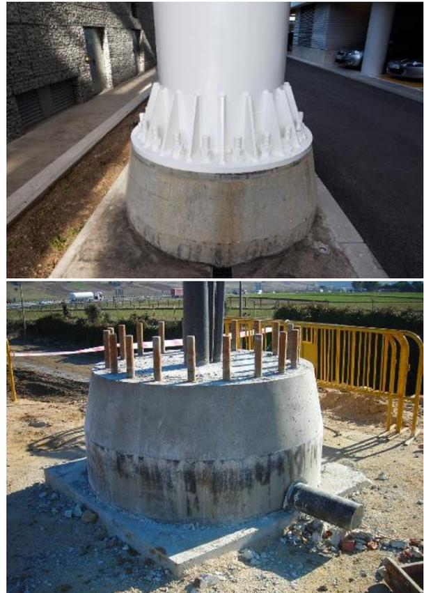
**Figura 17.** Plinto y placa base de los pilares (parte superior), mostrando la bajante instalada durante la construcción (parte inferior).
