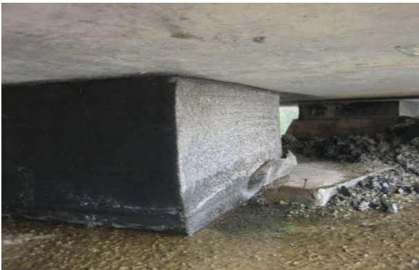
Figura 3. Apoyo reptado
