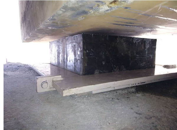
Figura 4. Sistema antirreptación
