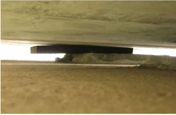
Figura 2. Apoyo reptado
