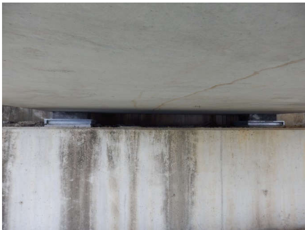
Figura 13. Actuación en estribos
