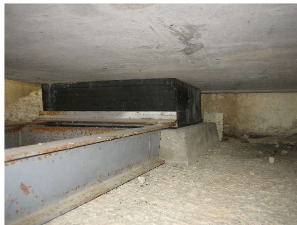
Figura 12. Antirreptación en estribos
