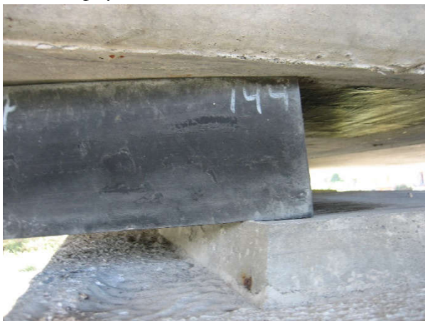
Figura 10. Apoyo de pila
