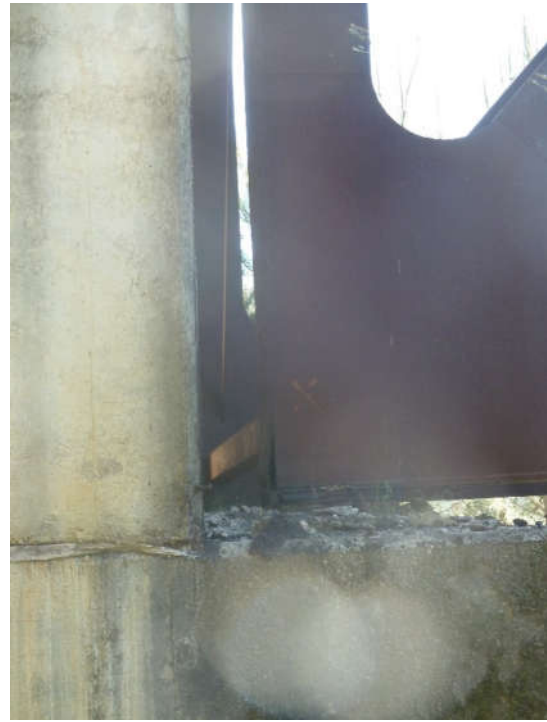
Figura 9. Culata celosía metálica
