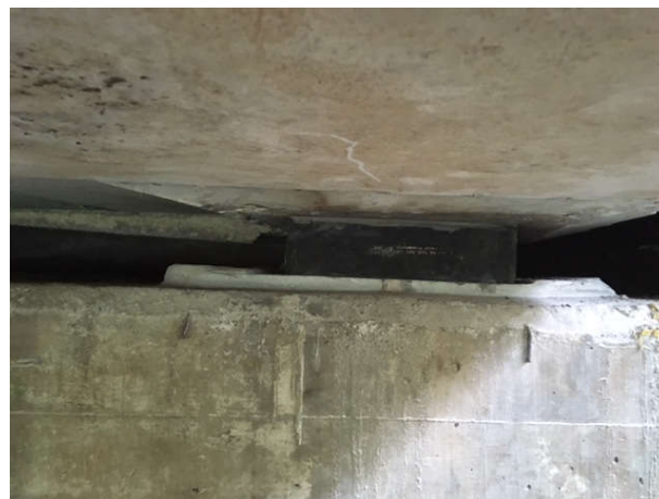
Figura 17. Apoyo reparado
