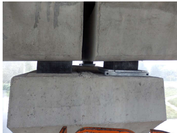
Figura 14. Actuación en pila
