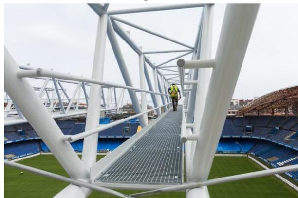
Figura 17. Colocación de celosías
