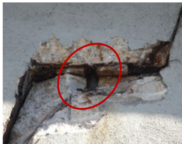
Figura 12. Cata para comprobación de existencia de pernos de anclaje en lado Valencia (V-3).
