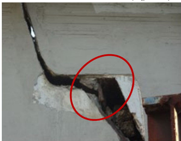
Figura 11. Pernos de anclaje existentes en el lado Madrid del vano V-3 observados durante maniobra de izado.
