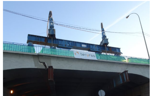
Figura 10. Pórtico de izado preparado para maniobra en vano V-3.
