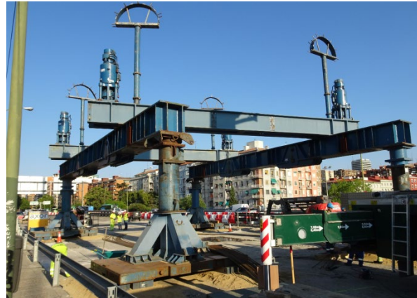
Figura 7. Sistema de izado colocado sobre la estructura.
