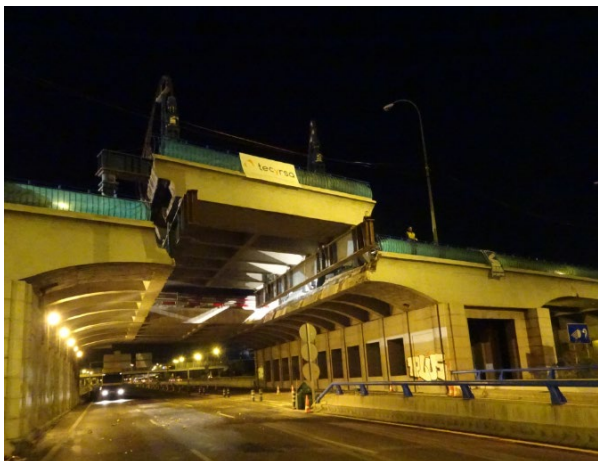
Figura 14. Vano isostático de V-3 izado.
