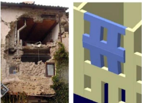
Figure 7. Fallo de fábrica por flexión perpendicular a su plano.
