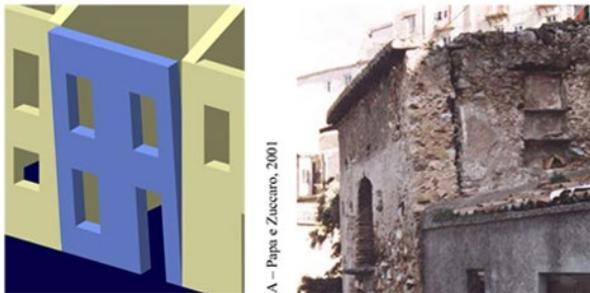
Figure 6. Fallo fuera de plano motivado por la falta de comportamiento de diafragma de la cubierta, que no sujeta los muros en el plano perpendicular de los mismos.
