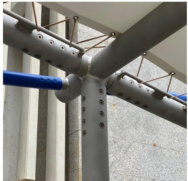
**Figura 5. Nudo atornillado y desmontable**
