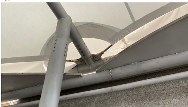
Figura 10. Cable tensor en contorno de membrana
