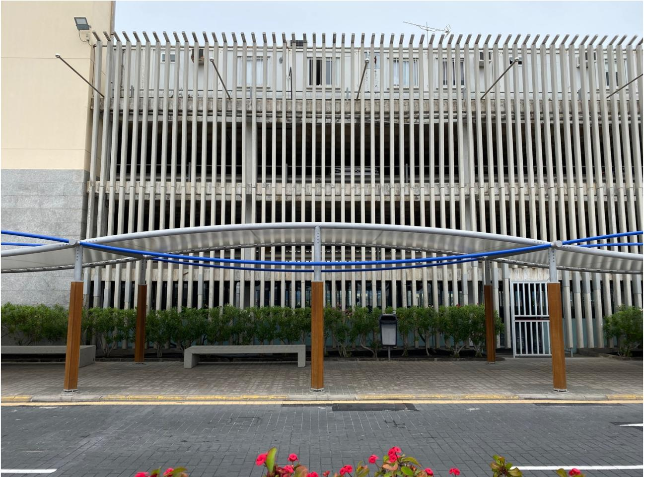
**Figura 4. Alzado sinusoidal de los perfiles longitudinales**
